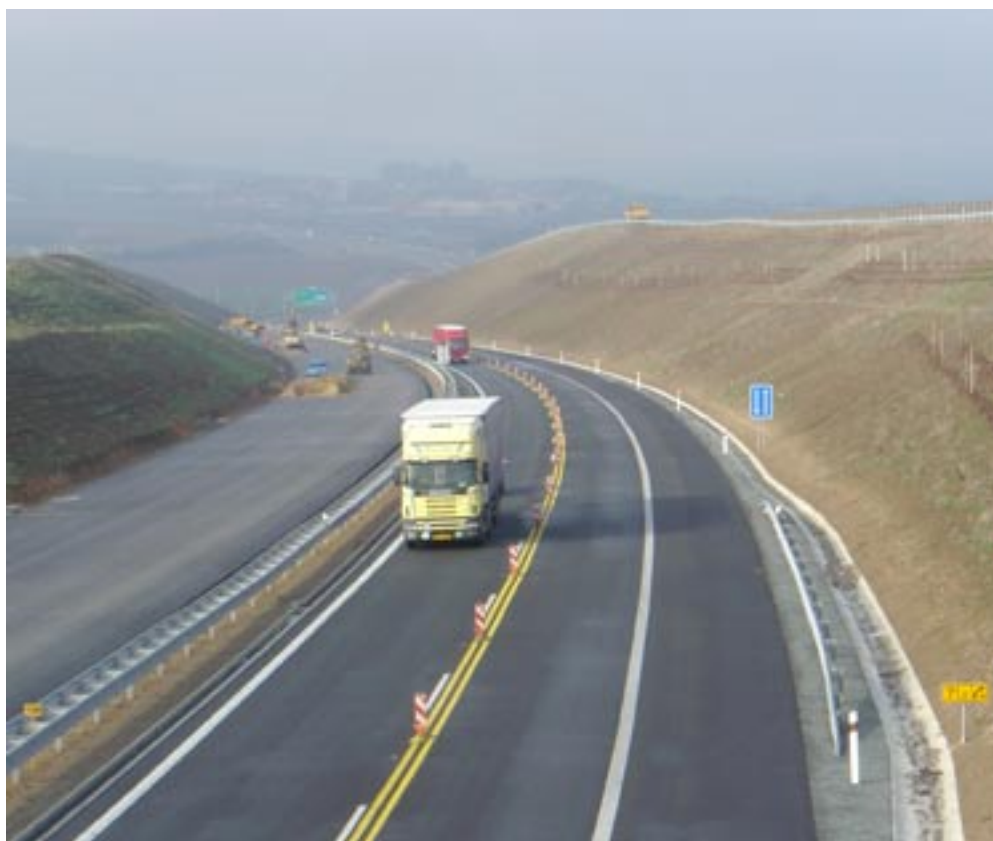
Dálnice D5, východní část plzeňského obchvatu (dočasně v polovičním profilu)
