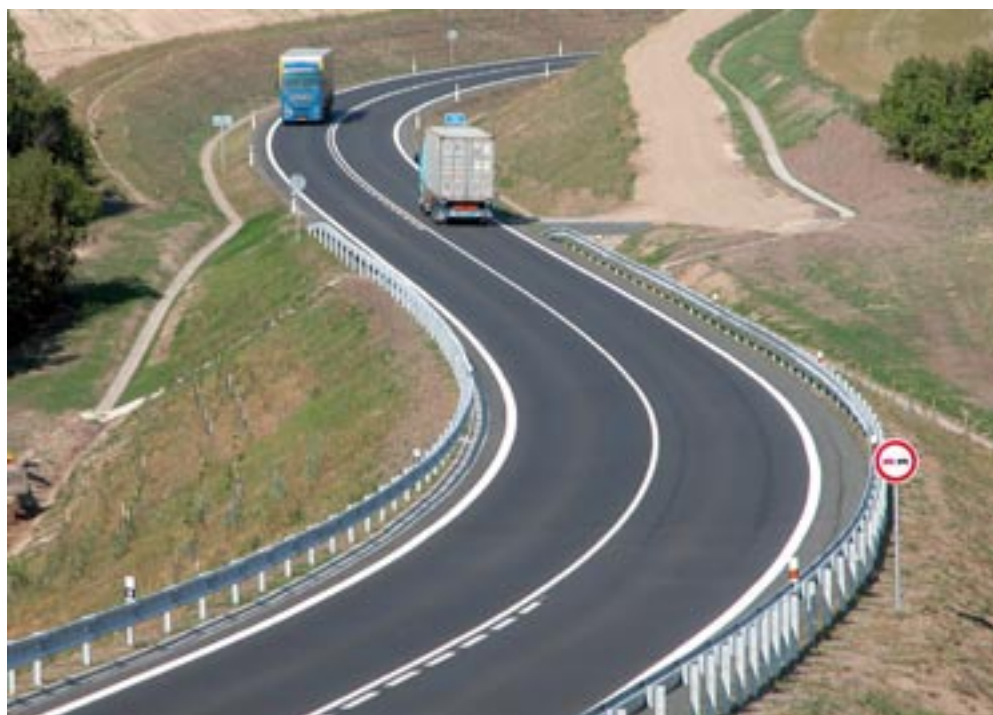
Silnice I/16, úsek Velvary – Nová Ves
