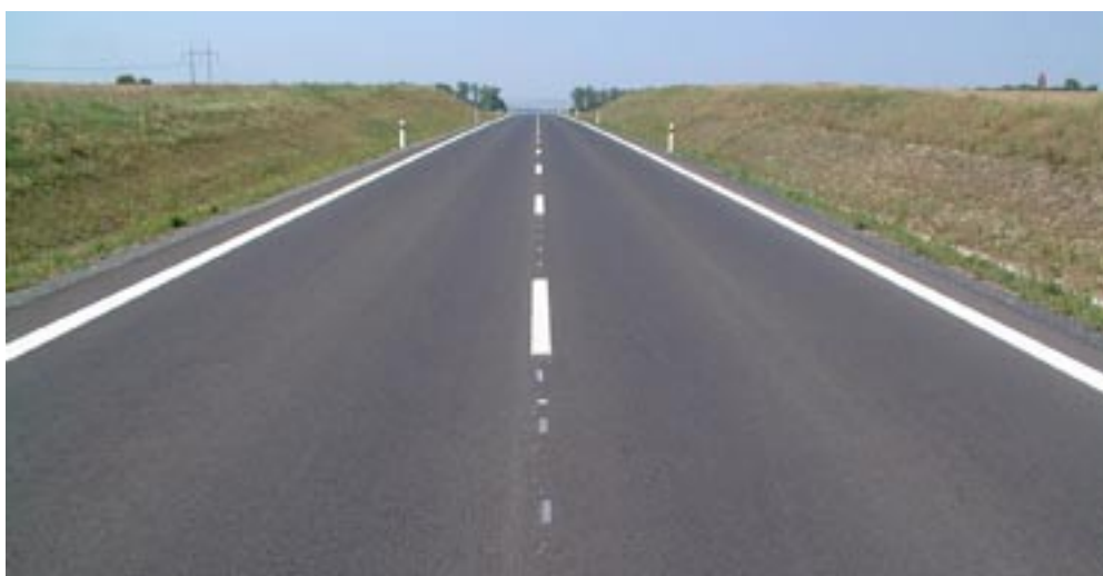
Silnice I/16, úsek Velvary – Nová Ves
