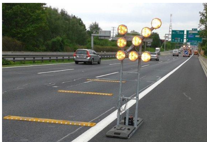
Správné umístění prahů u světelné předzvěsti a daleko před výstražným vozíkem
